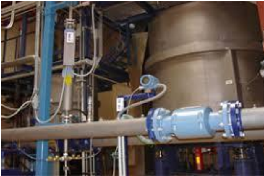
Fig. 3.2 Ejemplo de instalación Master Meter
